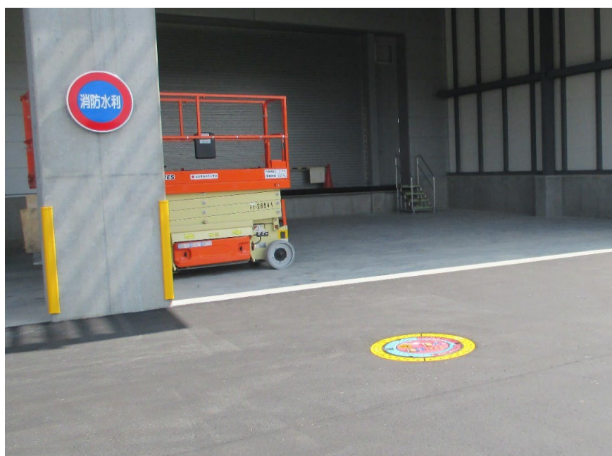
令和5年6月13日完成 40 m 型耐震性貯水槽(横沼地内)
