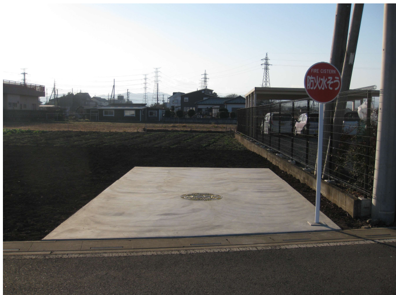
令和2年12月17日完成 40m 3 型耐震性貯水槽(町屋地内)
