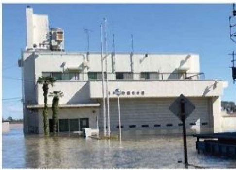
▲令和元年度台風19号で水没した坂戸消防署東分署
