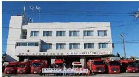
▲消防本部・坂戸消防署
